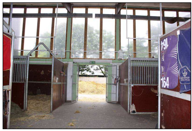
...und jetzt, die gleiche Stelle von innen: hell, luftig und freundlich
